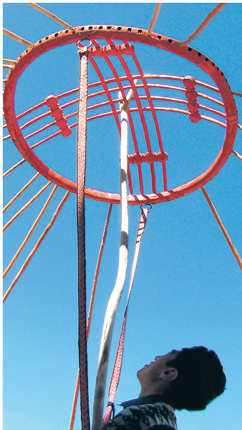
Aufbau einer kasachischen Jurte: Nach dem Gerippe wird der Shangyrak, das Dach der Jurte bzw. der Rauchabzug, aufgestellt. [Schlager]
